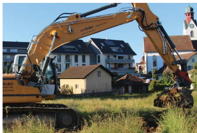
Der eigentliche Spatenstich erfolgte durch den Bagger.
