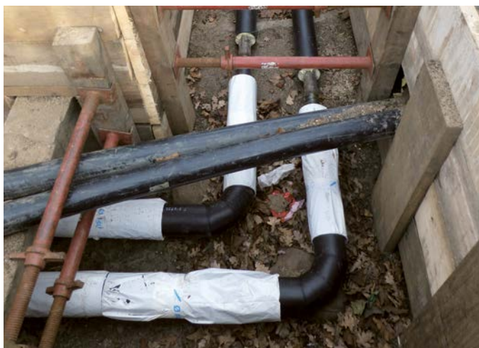
Die Investitions- und Unterhaltskosten für Fernwärmeleitungen sind hoch.
