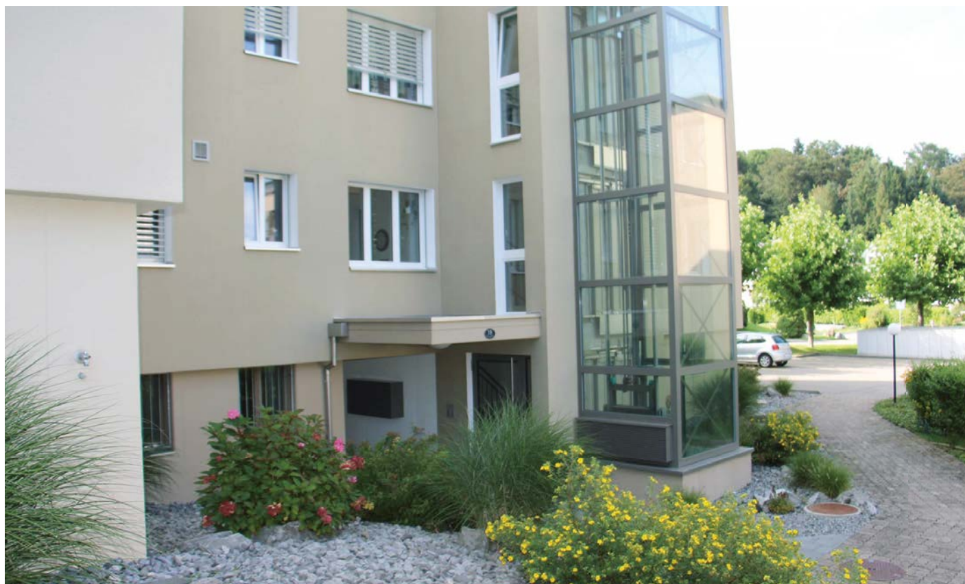
Die Liftanlagen sehen nach der Sanierung genau gleich aus wie bei der Obere Erlen 19.
